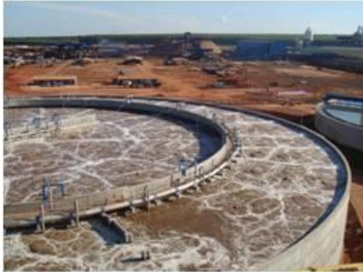
**Figura 2.3.5.6-1. Tanque de aeração.**
