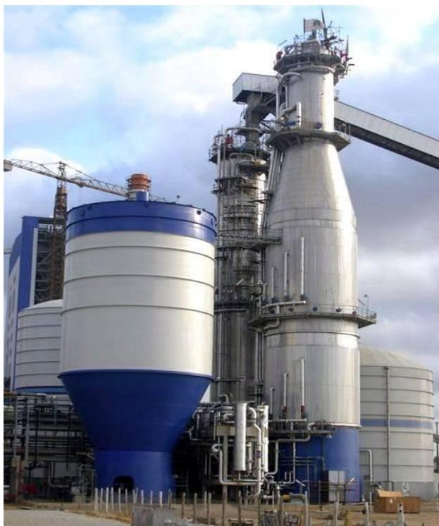
**Figura 2.3.5.1-3. Planta de cozimento dos cavacos de madeira.**
