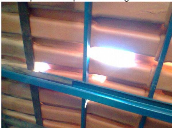
**Figura 3** – Telhas quebradas provocando goteiras. Fonte: *in-loco*.
