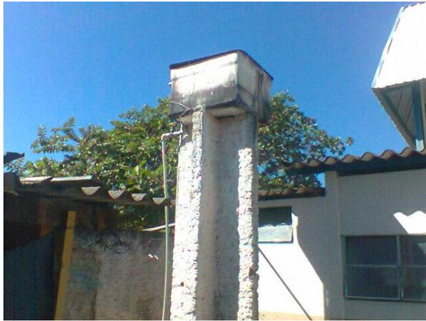
**Figura 23** – Caixa d'água com vazamento. **Fonte:** *in-loco*.
