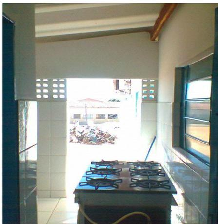
**Figura 22** – Fogão de seis bocas sem coifa gerando calor. **Fonte: in-loco.**
