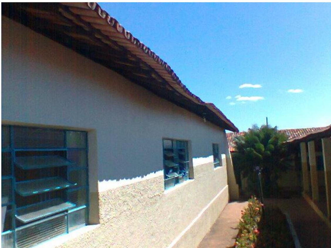
**Figura 7** – Cobertura com empenamento. **Fonte: in-loco.**
