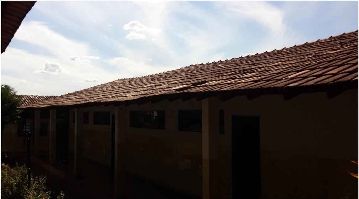
**Figura 8** – Cobertura com empenamento e telhas com bolor. **Fonte: in-loco.**
