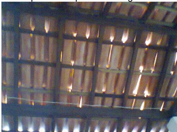
**Figura 2** – Telhas quebradas provocando goteiras. Fonte: *in-loco*.
