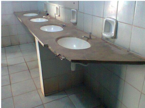
**Figura 15 – Bancada com armação exposta. Fonte: *in-loco*.**
