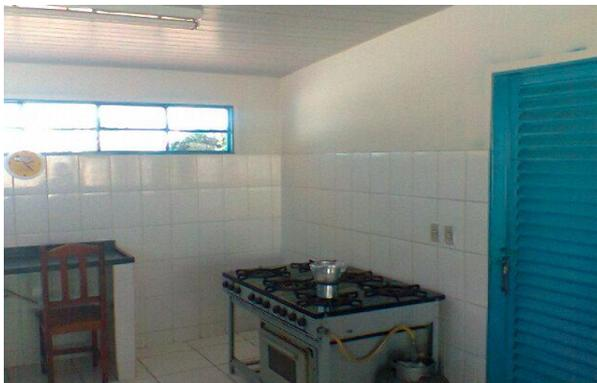
**Figura 21** – Fogão de seis bocas sem coifa gerando calor no interior da cozinha.
