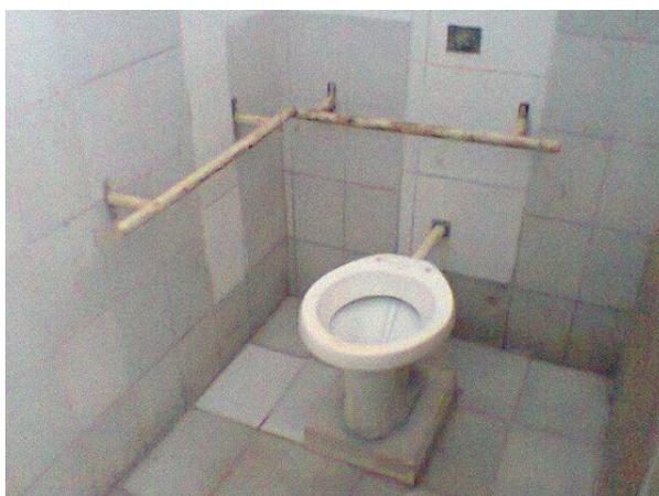
**Figura 18** – Barra de apoio para deficiente enferrujada. **Fonte: in-loco.**
