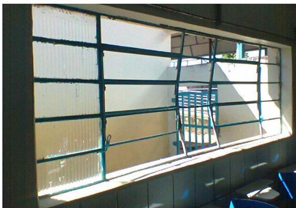
**Figura 10** – Janela com vidros quebrados e esquadria retorcida. **Fonte:** *in-loco*.
