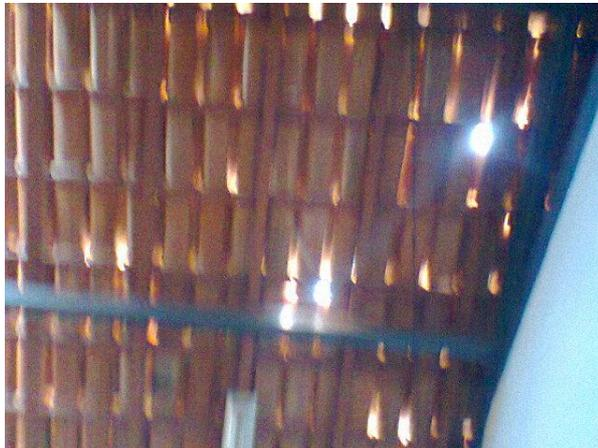
**Figura 1** – Telhas quebradas provocando goteiras. Fonte: *in-loco*.
