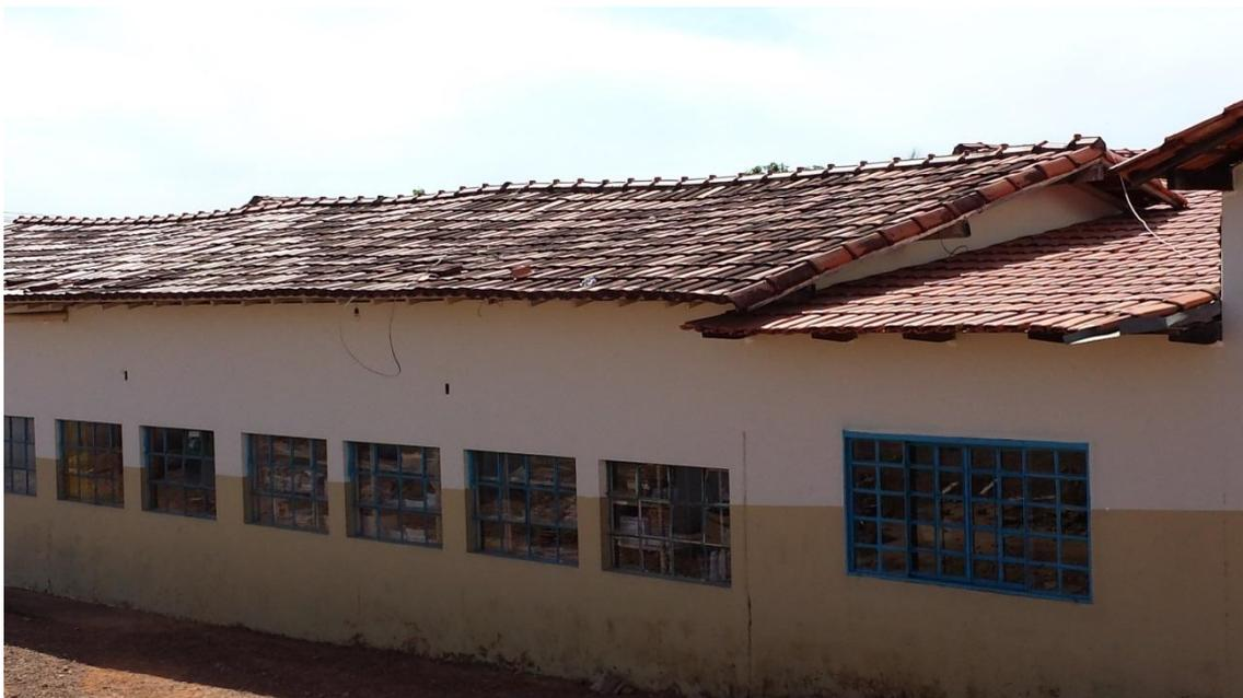
**Figura 6** – Cobertura em madeira com empenamento da cumeeira. **Fonte: in-loco.**
