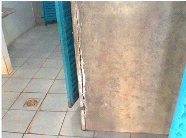
**Figura 14 – Divisória com fissura. Fonte: *in-loco*.**
