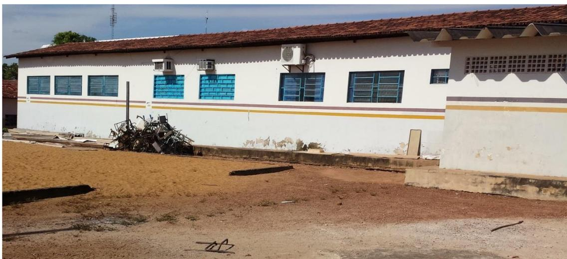
**Figura 5** – Cobertura em madeira do bloco III com empenamento da cobertura e presença de bolor nas telhas. **Fonte: in-loco.**
