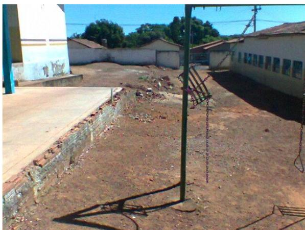
**Figura 19** – Distância entre as unidades com diferença de nível em torno de 140cm, em solo natural sem cobertura, prejudicando a locomoção dos usuários da escola. **Fonte: in-loco.**
