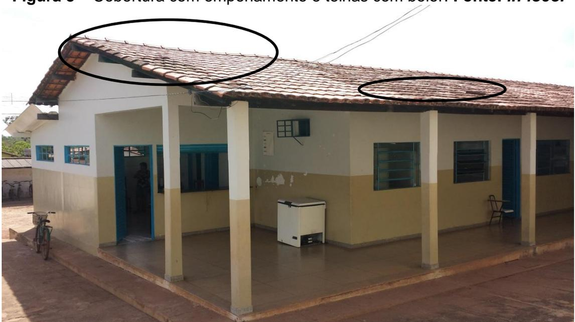
**Figura 9** – Cobertura com empenamento de cumeeira, assim como em regiões intermediárias do pano de cobertura. **Fonte: in-loco.**
