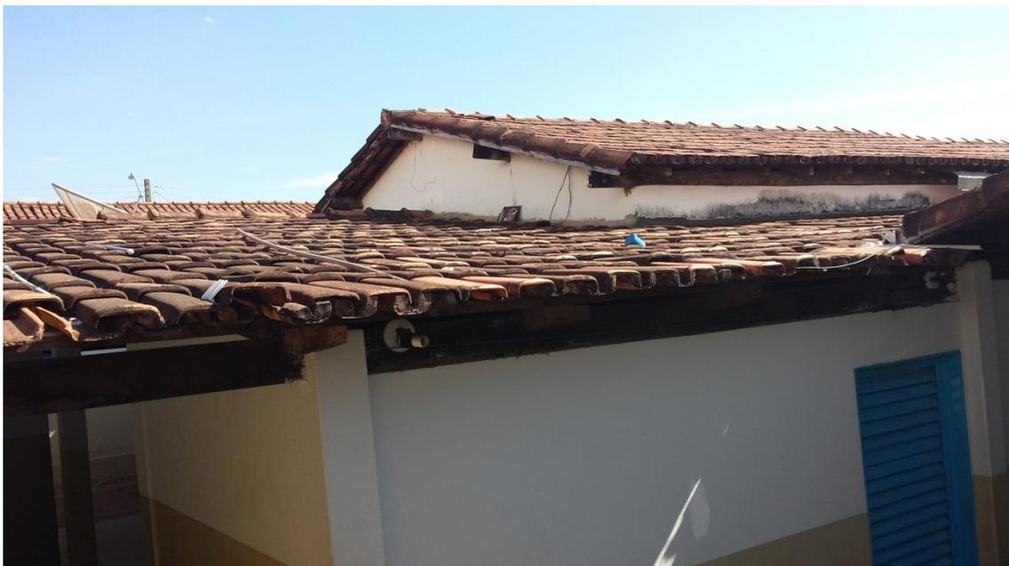
**Figura 4** – Cobertura com telhas quebradas e presença de bolor. **Fonte: in-loco.**
