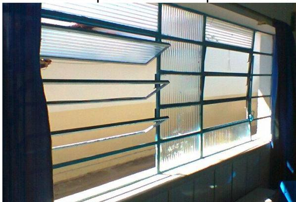
**Figura 12** – Janela com vidros quebrados e esquadria retorcida. **Fonte:** *in-loco*.
