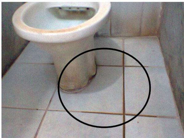
**Figura 16** – Vaso sanitário com vazamento. **Fonte: in-loco.**
