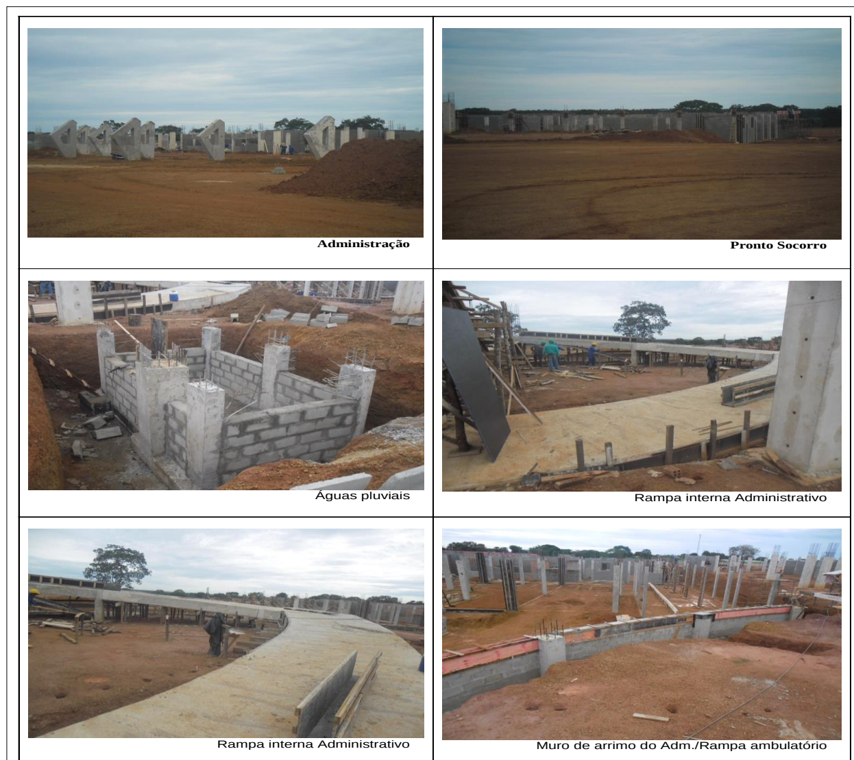
Imagem 1 – Relatório Fotográfico da Obra do Hospital Geral de Gurupi, 18 de março de 2015
