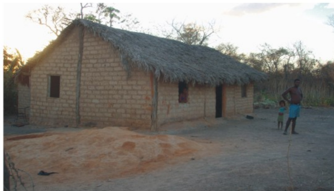
Figura 57 - Domicílio rural em situação precária, com telhado de palha, que impossibilita captação de água de chuva
