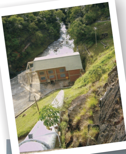
Figura 41 - Fotos da PCH da Cacheira do Registro no rio Sobrado
