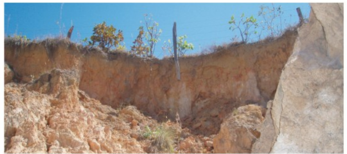
Figuras 53 e 54 - Voçorocas decorrentes de más condições de drenagem em estrada rural no município de Arraias – Sudeste do Tocantins
