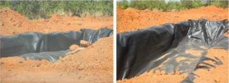
Após incineração dos RSS o resíduo (pó) é destinado ao Aterro Sanitário em valas específicas – impermeabilizadas. Para essas mesmas valas são destinadas carcaças de animais.
