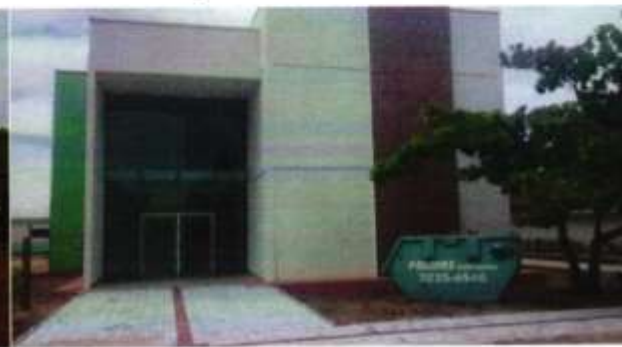
Figura 4 – Obra na UFT
