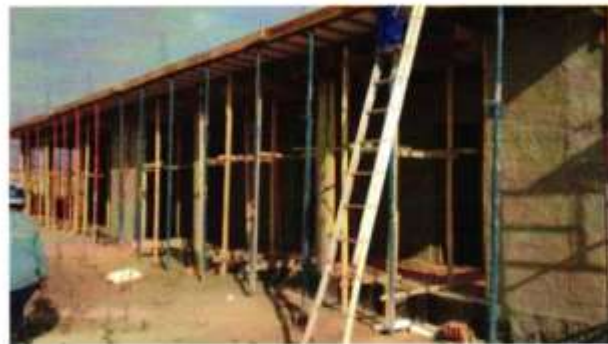
Figura 2 – Obra na Unitins
