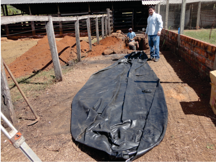
Figura 16 - Para a montagem, o biodigestor deve ser aberto e desenrolado.
