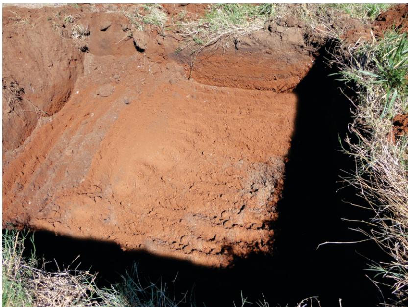
Figura 15 – Escavação para lagoa de biofertilizante.
