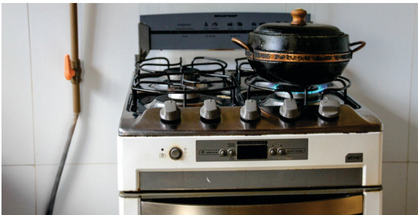
Figura 22 - Veja que o cano para condução do biogás pode ser de PVC, mas não devem ser utilizados joelhos que dificultem a passagem do gás.
