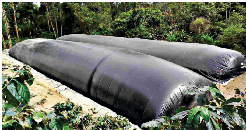
Figura 1 - Biodigestor tubular de fácil implantação e manutenção, sendo um dos modelos com melhor relação custo benefício.
