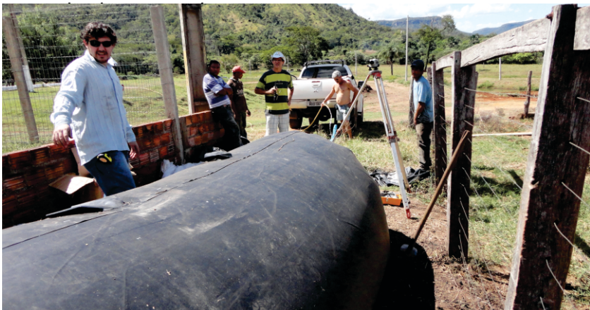
Figura 17 - Em seguida, o biodigestor é inflado. Nesse caso utilizou-se o gás do escapamento do carro para inflar.
