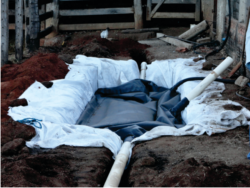
Figura 19 - As tubulações de entrada, saída e limpeza são fixadas em locais específicos do biodigestor.
