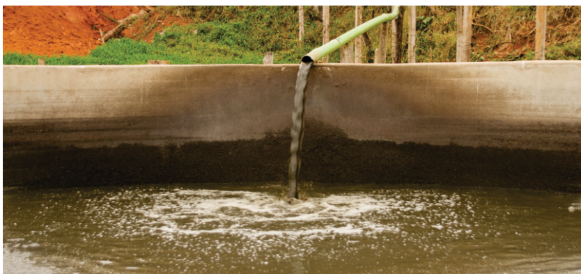
Figura 25 – A saída do biofertilizante na lagoa ocorre na medida em que é acrescentado material no biodigestor.
