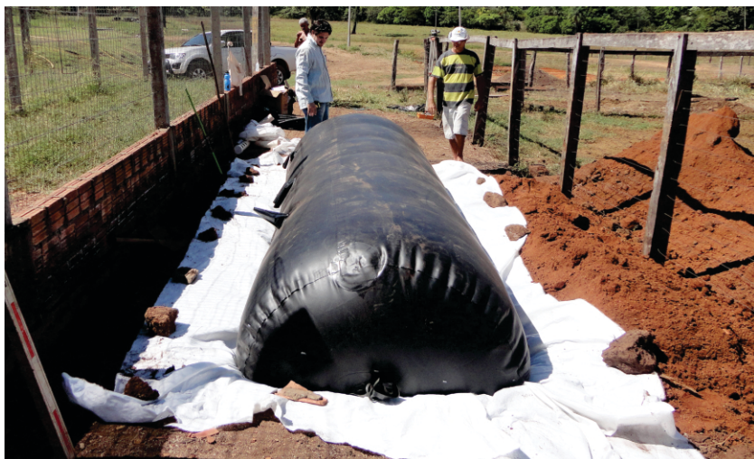
Figura 18 - Estenda o geotêxtil sobre toda a superfície da vala de modo a oferecer maior proteção à membrana de PVC do biodigestor. Em seguida, apoia-se o biodigestor sobre essa manta.
