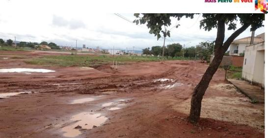
Verificou-se que o setor não possui pavimentação asfáltica, e que com os trabalhos da implantação da rede de esgotamento sanitário, que ocorreu em toda a quadra, os problemas de trafego de veículos internos foram potencializados.
