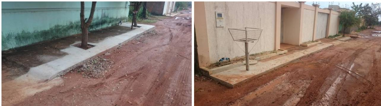
Nota-se que a reposição das calçadas dos imóveis segue o mesmo padrão de acabamento, utilizando o mesmo material que originalmente existia. Quanto ao alinhamento das calçadas só será possível a correta locação do meio-fio no momento em que for executada a pavimentação asfáltica da quadra.
