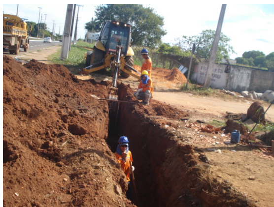
EXECUÇÃO DE REDE COLETORA
