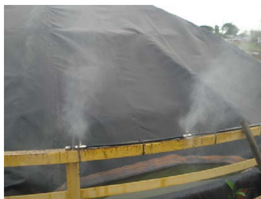
APLICAÇÃO DE NEUTRALIZADOR
