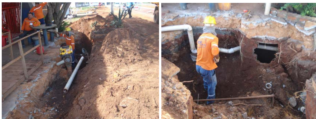
EXECUÇÃO DE LIGAÇÕES
