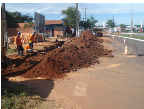
EXECUÇÃO DE REDE COLETORA
