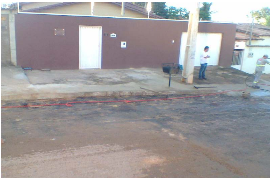
Figura 03. Limpeza da calçada.
