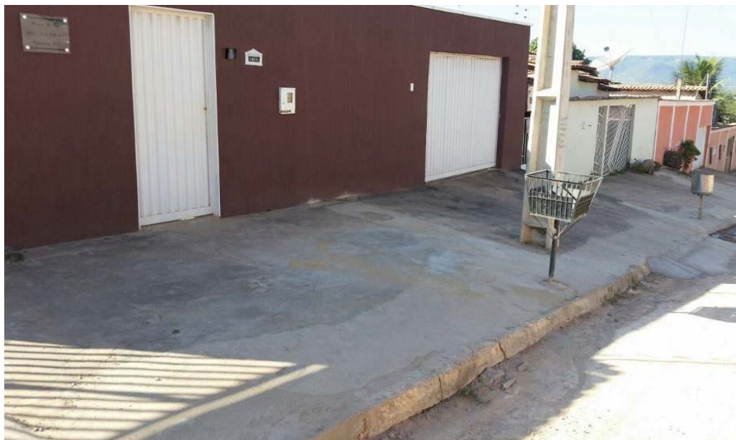
Figura 02. Recuperação da calçada
