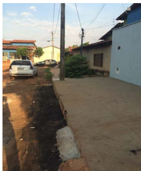
Recomposição asfáltica realizada
