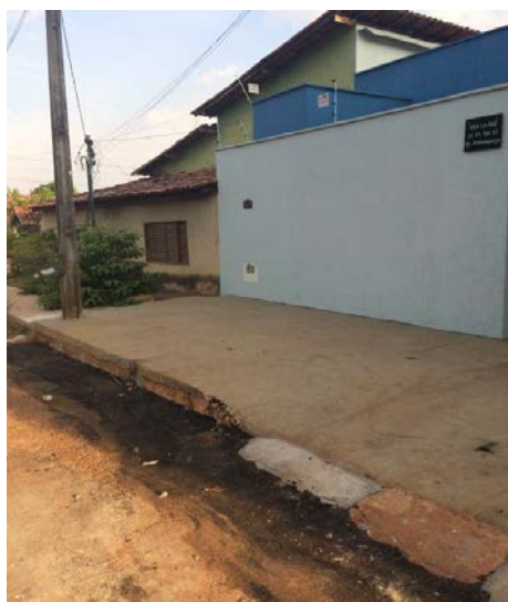
Recomposição asfáltica realizada
