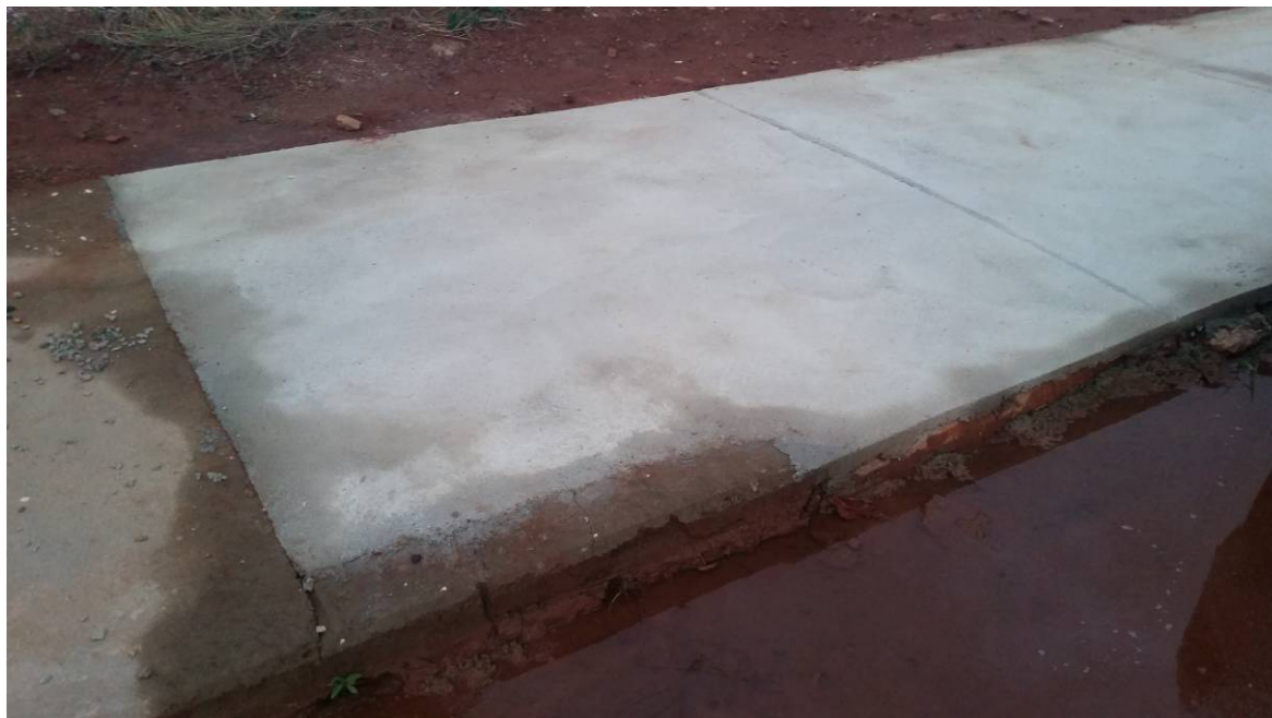
Figura 1 – Serviço de recomposição de calçada executado
