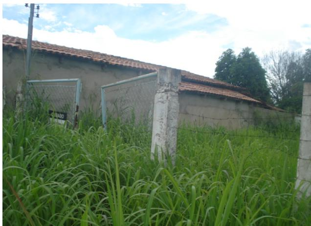
Fotos 26 e 27 - Observar portão e cerca necessitando de recuperação, além da vegetação tomando conta da área.
