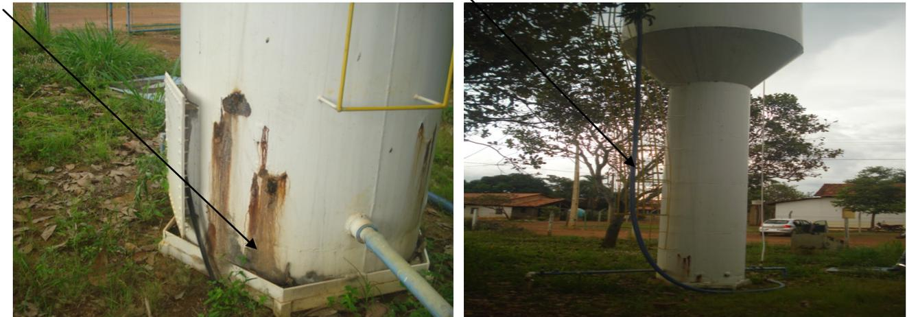
Fotos 35 e 36 - Danos com vazamentos na base do reservatório e tubulação em contato direto com a água tratada, caracterizando coleta indevida de água.
