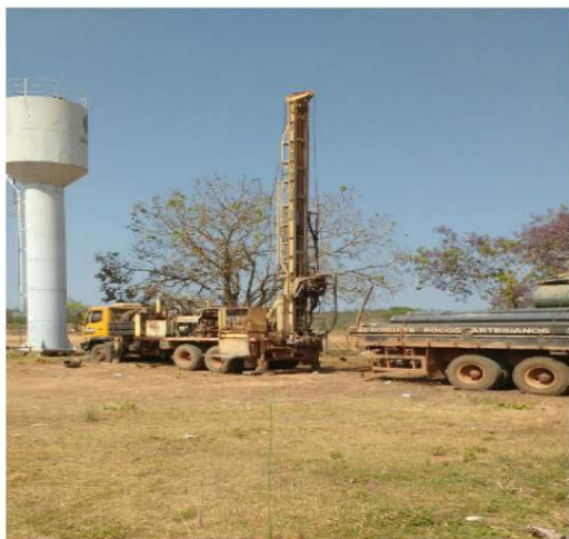
Figura 6 - Perfuração do poço
