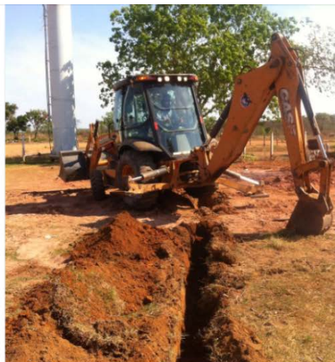
Figura 9 - Execução de adutora
