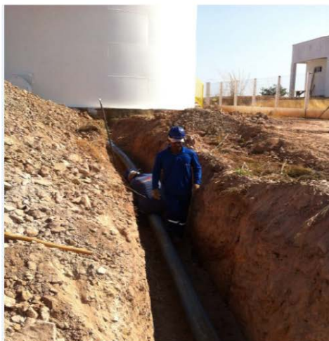
Figura 7 - Execução da adutora do poço ao RAP
