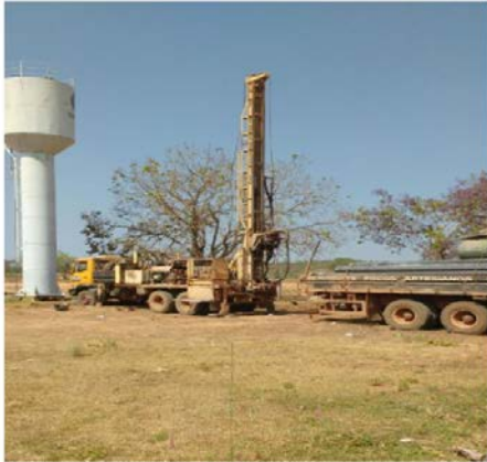
Figura 6 - Perfuração do poço
