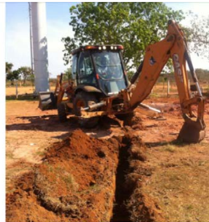
Figura 9 - Execução de adutora
