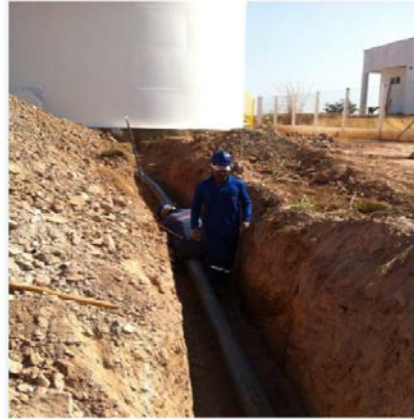
Figura 7 - Execução da adutora do poço ao RAP
