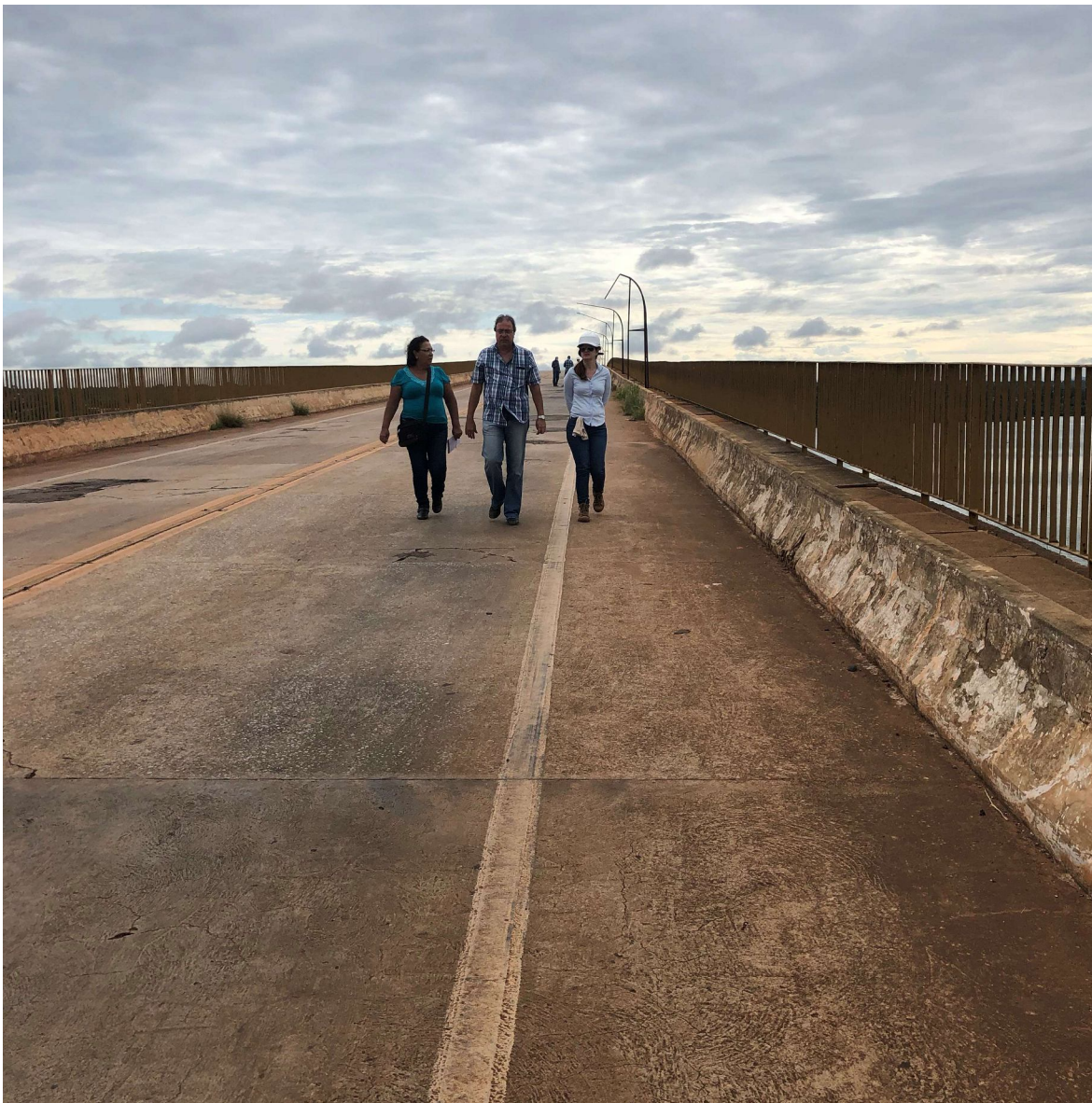
Figura 18 – Vista do tabuleiro, aspectos gerais.
