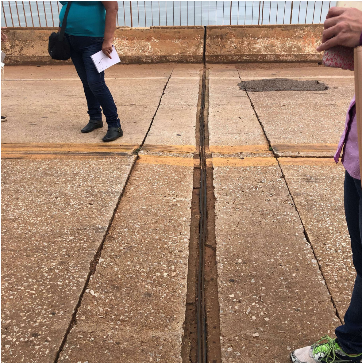
Figura 14 – junta de dilatação, aspectos gerais.
