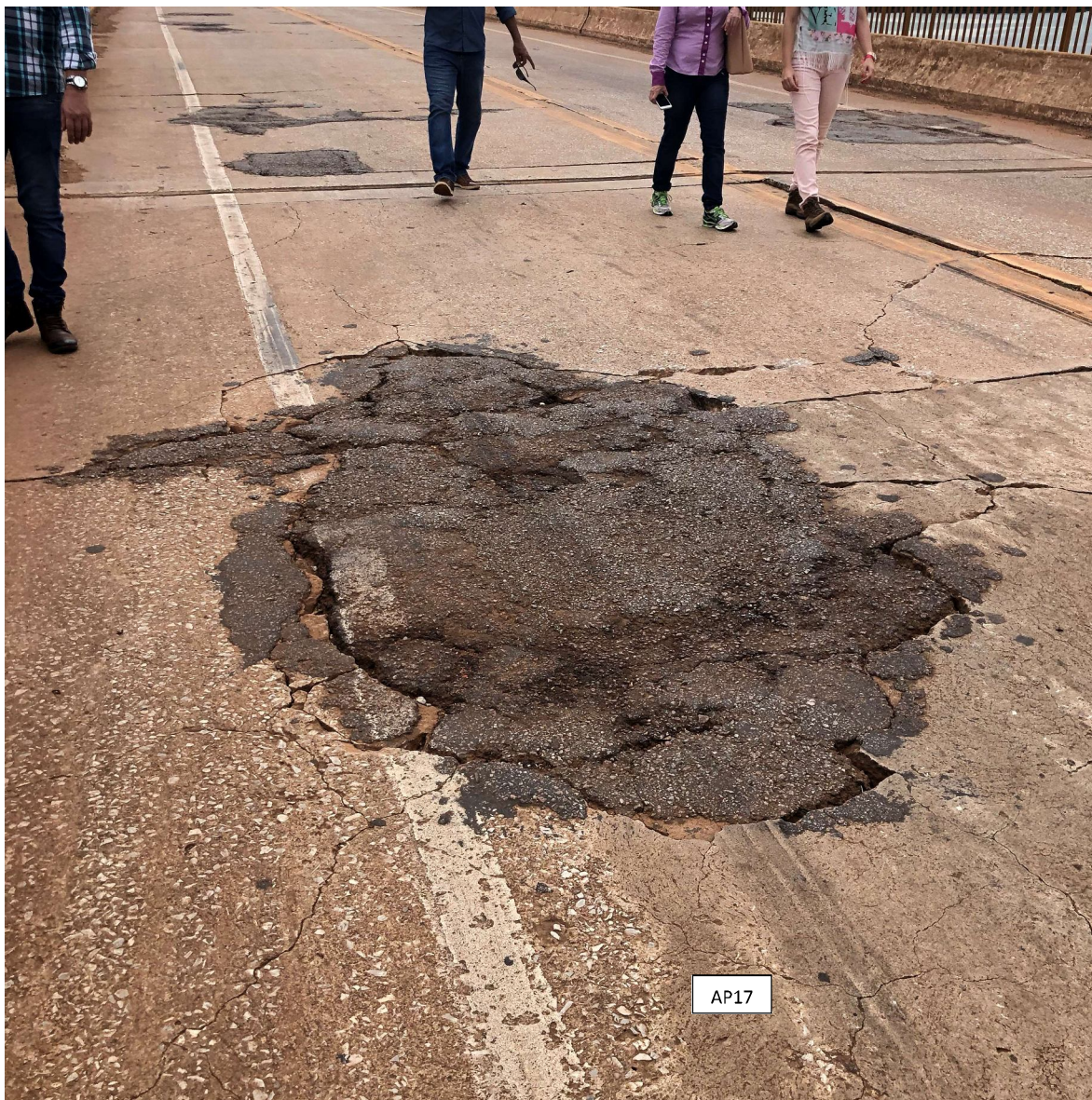
Figura 15 – danificação da laje do balanço do pilar.
