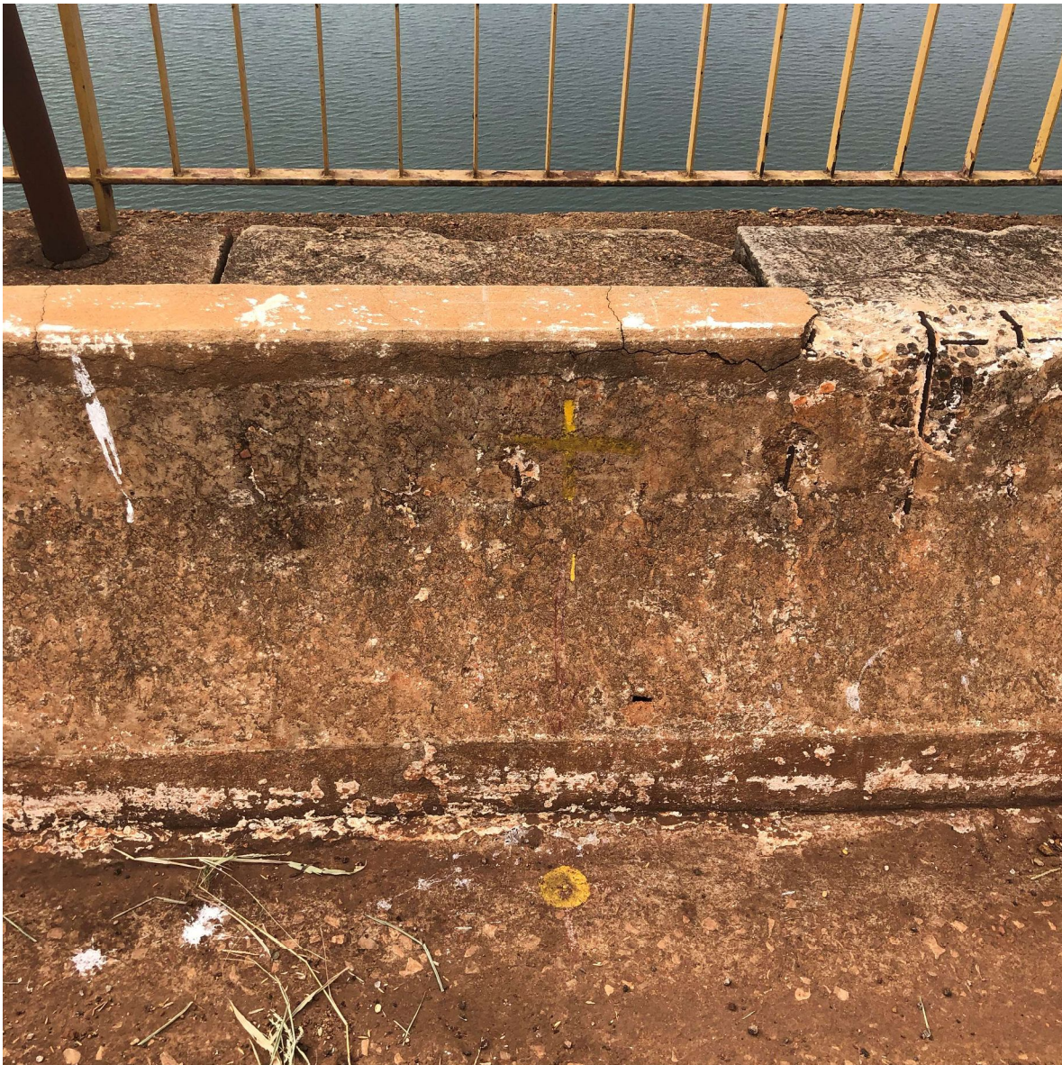
Foto 11 – Vista do guarda-rodas danificado.
