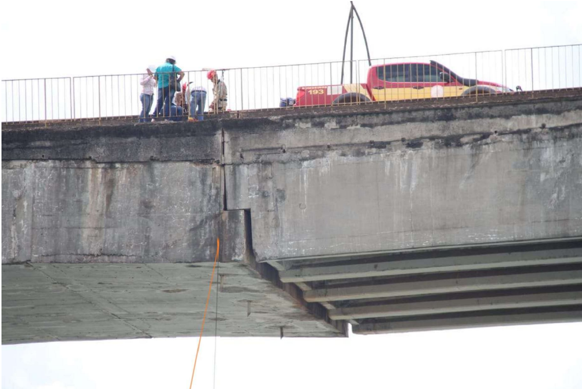
Foto 2 – Detalhe do apoio do tramo de ligação entre pilares.
