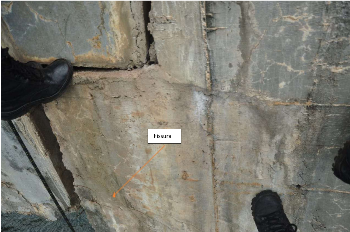
Foto 3 - Aspectos do dente de apoio do balanço.
