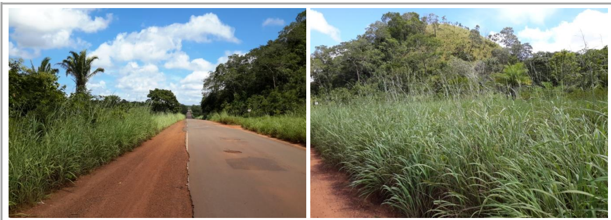
Figura 3.39 DIFERENTES FEIÇÕES EVIDENCIANDO ÁREAS DE DECLIVIDADE SUAVEMENTE ONDULADA A ONDULADA (MORROTE)
