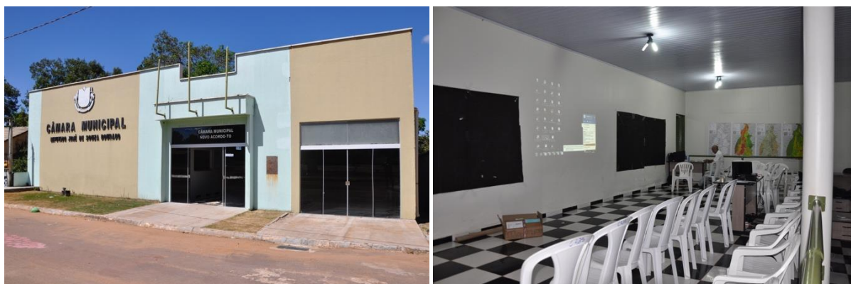
Figura 3.80 IMAGENS DO ESPAÇO E INFRAESTRUTURA DA SEDE DA OFICINA TÉCNICA DE NOVO ACORDO - ZEE-TO
