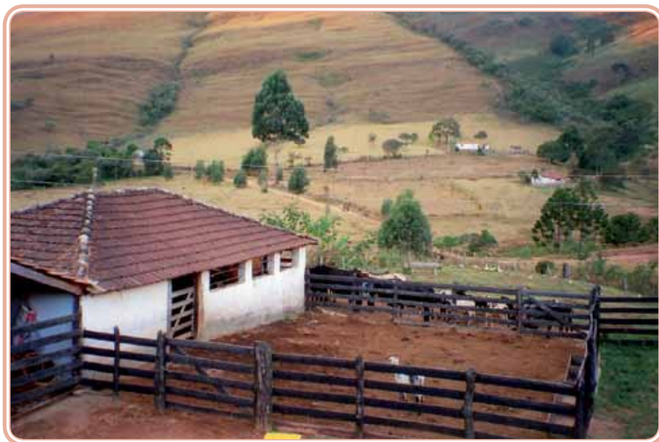
Figura 21: Exemplo de instalação rural.
