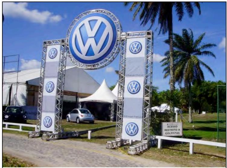
Figura 3 Pórtico em grid de alumínio. Fonte: [http://images01.olx.com.br/ui/17/03/77/1324385321\\_216089677\\_15-Portico-em-Grid-Box-Truss-e-com-a-Objective-Engenharia-de-Eventos-.jpg](http://images01.olx.com.br/ui/17/03/77/1324385321_216089677_15-Portico-em-Grid-Box-Truss-e-com-a-Objective-Engenharia-de-Eventos-.jpg)
