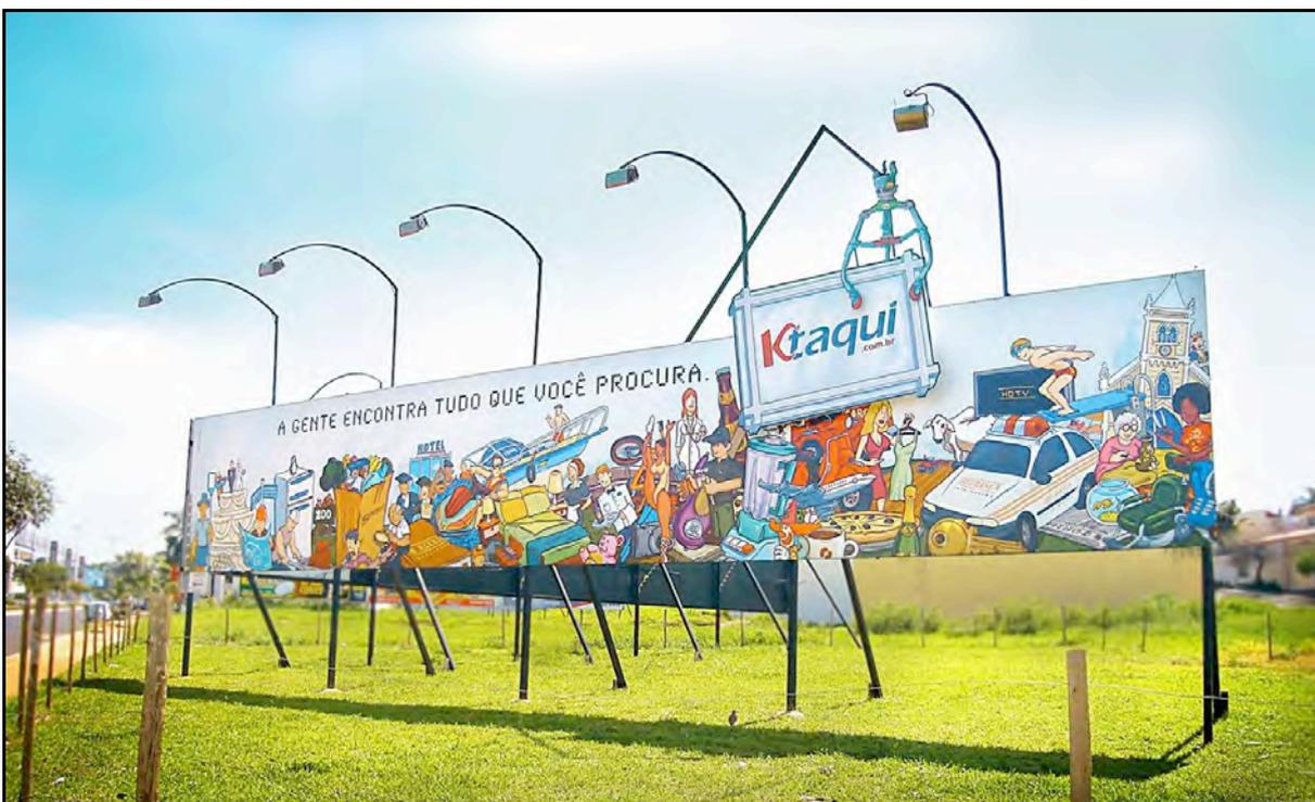
Figura 5 Pannel com estrutura de metalon. Fonte: [flaviomelo.files.wordpress.com](http://flaviomelo.files.wordpress.com)
