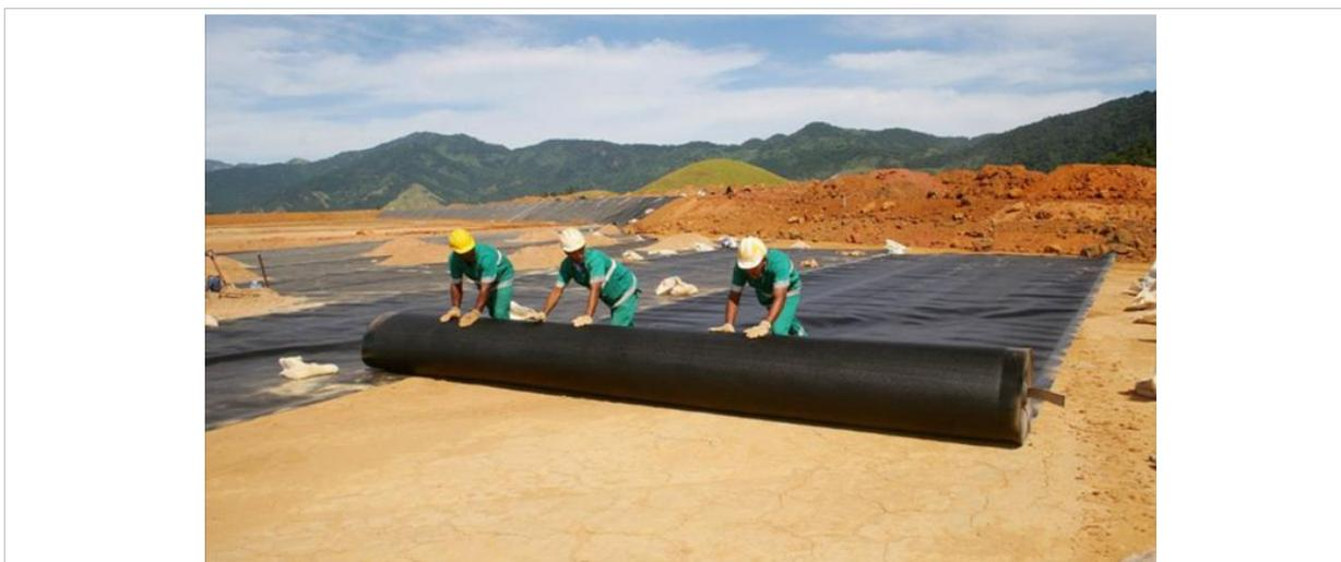
Figura 81: Impermeabilização com Geomembrana PEAD.
