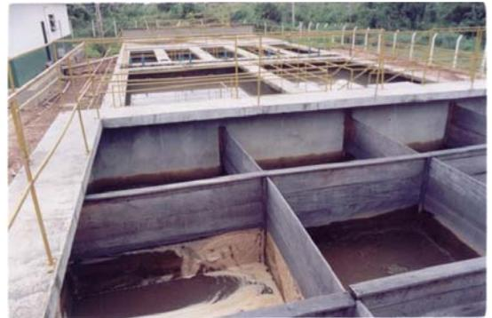
Figura 29 - Tratamento - decantação e filtragem
