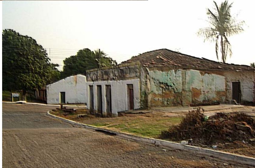
Figura 15 - Casas Comerciais na Avenida Goiás
