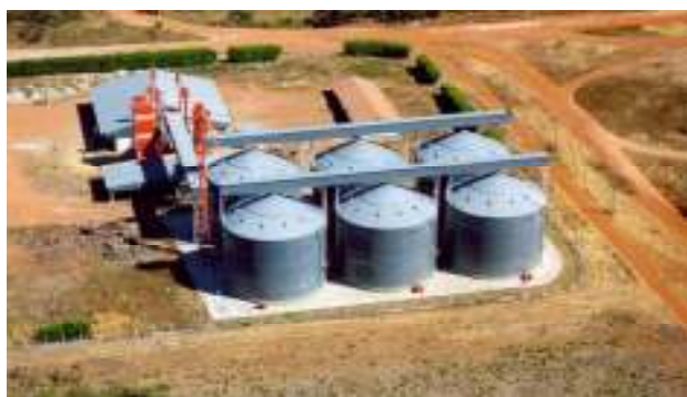
Silos em Gurupi - TO
