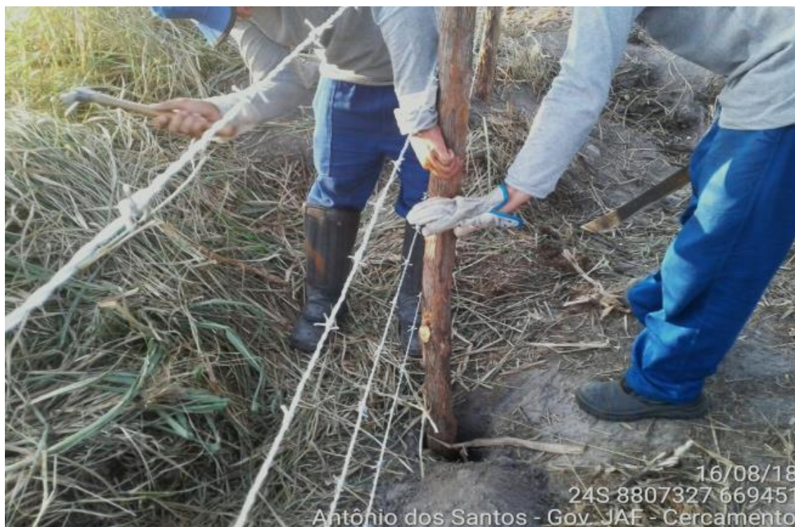
FIGURA 15. Construção de cerca com estacas de sabiá, posicionada no centro do aceiro anteriormente à limpeza do material vegetal residual da capina.
