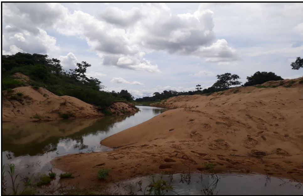
Imagem 03 – Canal de irrigação que tem ocasionado o assoreamento no Rio Formoso.
