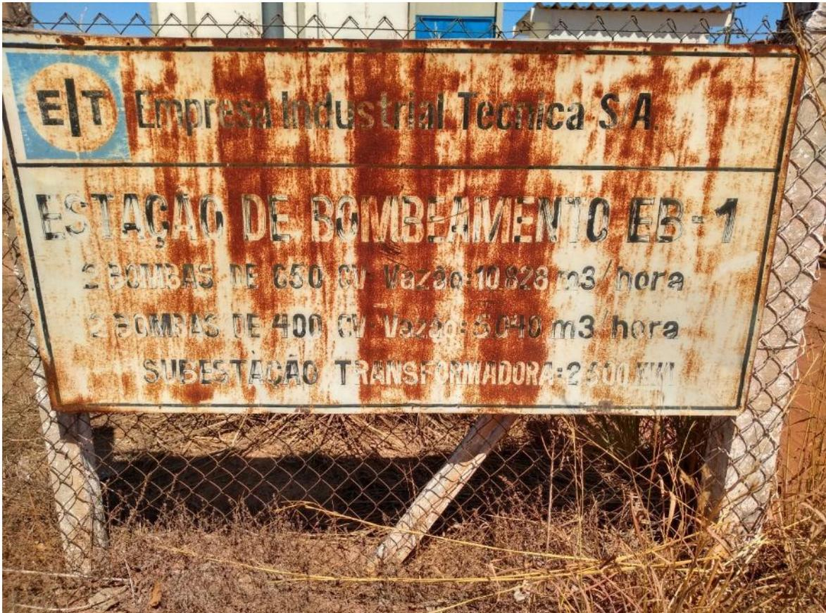
*Foto 22 - Placa de Identificação EB-01*
