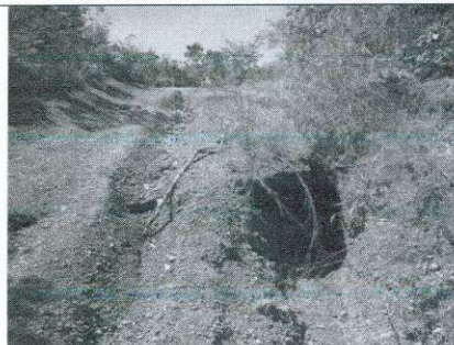
Fotos 05 e 06 – Km 32,20 - Detalhe de corte com afloramento de água e sulcos erosivos no eixo estradal à margem direita do córrego Preto. Interditada para veículos longos.
