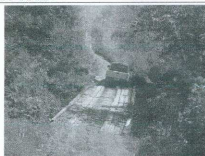
Foto 08 – Km 42.00 - Vista da ponte sobre o rio Preto com subida bastante acentuada, dificultando a passagem de veículos longos.
