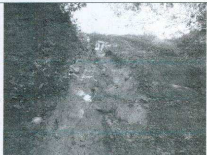
Fotos 05 e 06 – Km 32,20 - Detalhe de corte com afloramento de água e sulcos erosivos no eixo estradal à margem direita do córrego Preto. Interditada para veículos longos.
