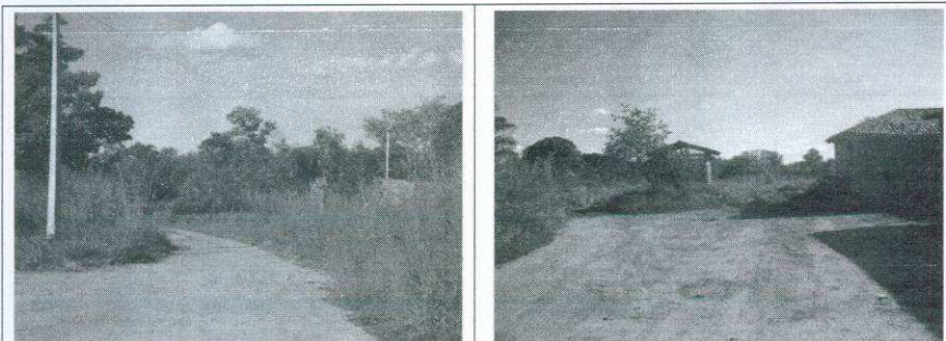
Fotos 07 e 08 - Km 24,60 – Vista do acesso e Aldeia Bela Vista. Final do trecho 02.
