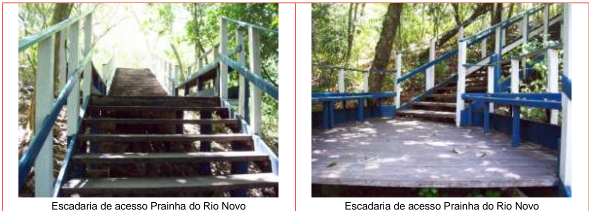
Figura 24: Escadaria de acesso à Prainha do Rio Novo – Município de Mateiros
